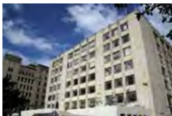
| EDIFICIO MURILLO TORO. Foto MUG
